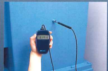
空調機器の能力試験・保守点検
