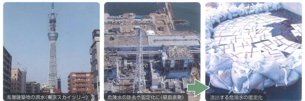
高層建築物の漏水(東京スカイツリー)
