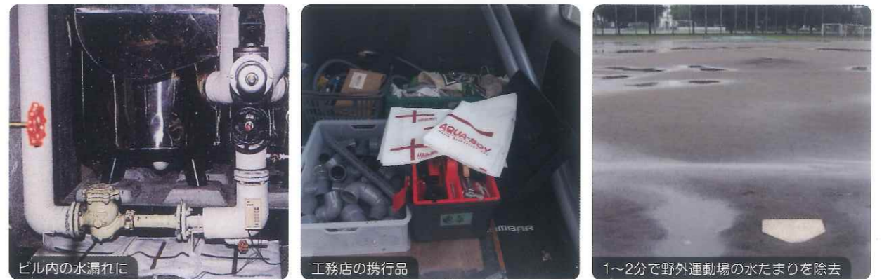
ビル内の水漏れに
